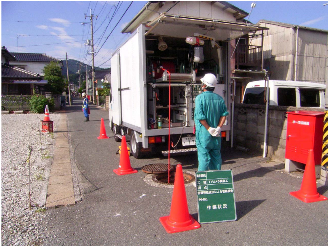
(2) ロボット挿入作業
