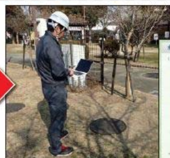
蓋閉め後の計測・通信動作確認
